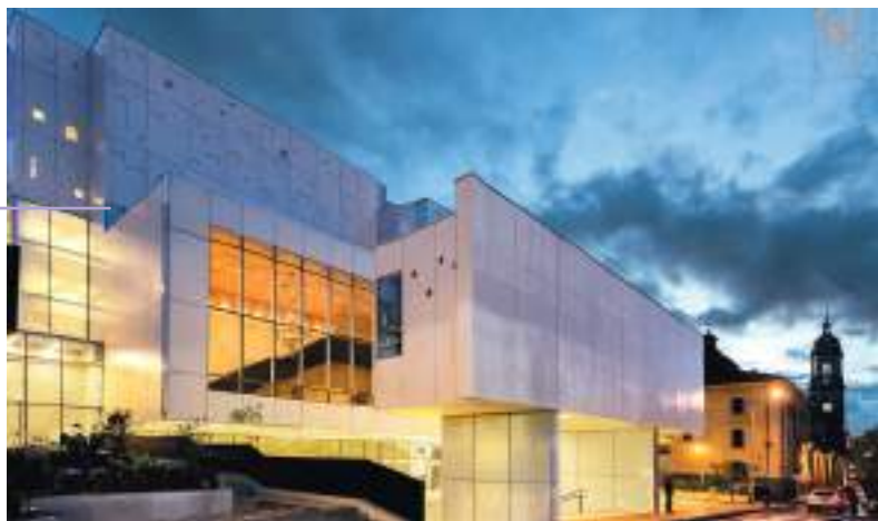
Arriba: espacios públicos intermedios entre lo público y lo privado. Abajo: contexto general de la inserción del proyecto en el contexto urbano.
