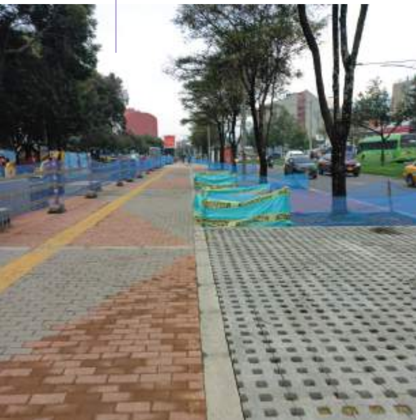
Fotografía de registro del desarrollo de la obra, vista hacia el norte.
