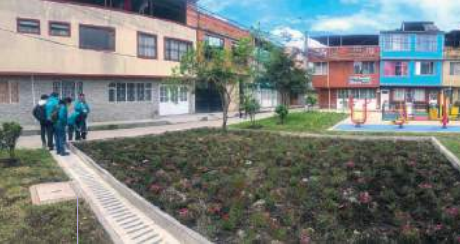
Vista a nivel de peatón del Sistema Urbano de Drenaje Sostenible (SUDS), jardín de bioretención. Esta solución ecológica se integra armoniosamente con el contexto, gestionando eficientemente las aguas lluvias y mostrando cómo la infraestructura verde puede embellecer el entorno.
